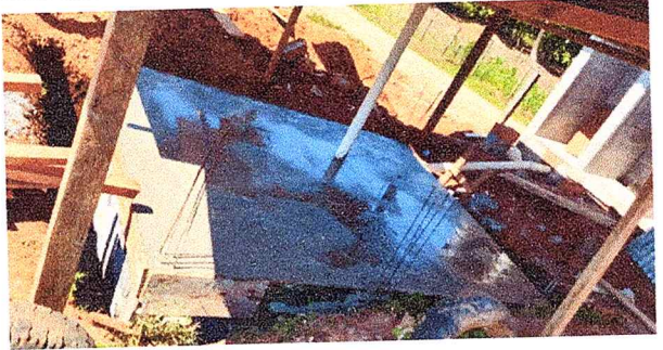
Foto 2: construccion de la terraza para la fosa septica con sistema de drenaje de los servicios sanitarios.
