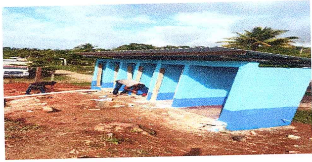
Foto 5: Conexión tubería con sistema de drenaje a la Fosa Séptica.
