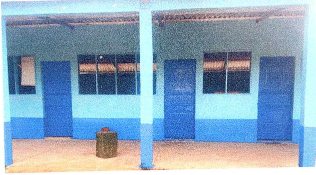
Foto 4: Colocacion de las puertas con chapa en las aulas para la finalizacion del Programa de mantenimiento de Edificios Escolares Publicas.
