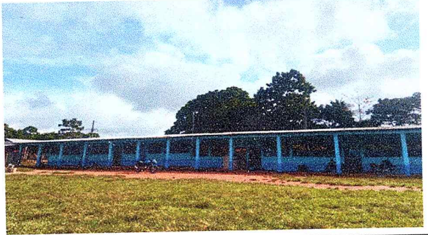
Foto 6: Pintada de las aulas mejoradas con el Programa de Mantenimiento de los Edificios Escolares Publicas.
