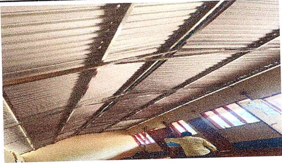
Foto1: Enlaminado de las 4 aulas con el apoyo del soldador contratado por la comunidad.
