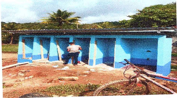
Foto 3: Colocacion de las puertas de los servicios sanitarios.
